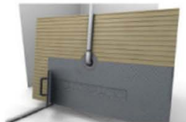
Peinar la base con cemento cola C2
